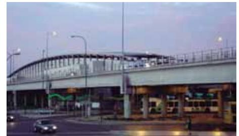
En el bandejón central de la Avenida Circunvalación de Américo Vespucio se emplazan estaciones de superficie. Se accede mediante pasarelas a una mesanina superior que se abalcona sobre los andenes. La presencia de la estación queda señalada por una gran cubierta ondulante cuya dinámica geométrica delata el paso y detención del tren. Los colores, la forma y su iluminación nocturna están diseñadas para ser leídas desde la velocidad de la autopista.
